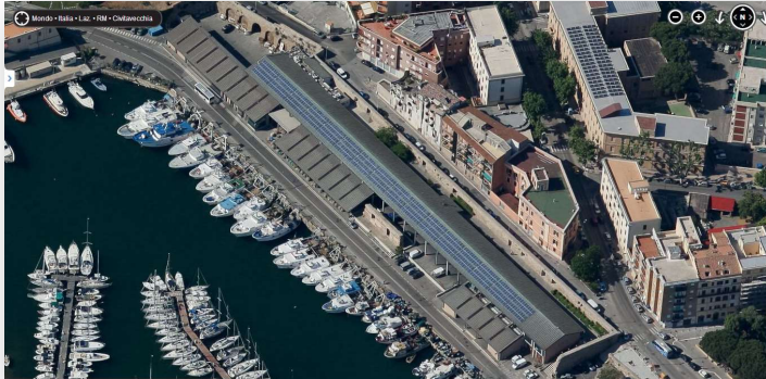
Vista aerea dell'impianto fotovoltaico della Darsena Romana
